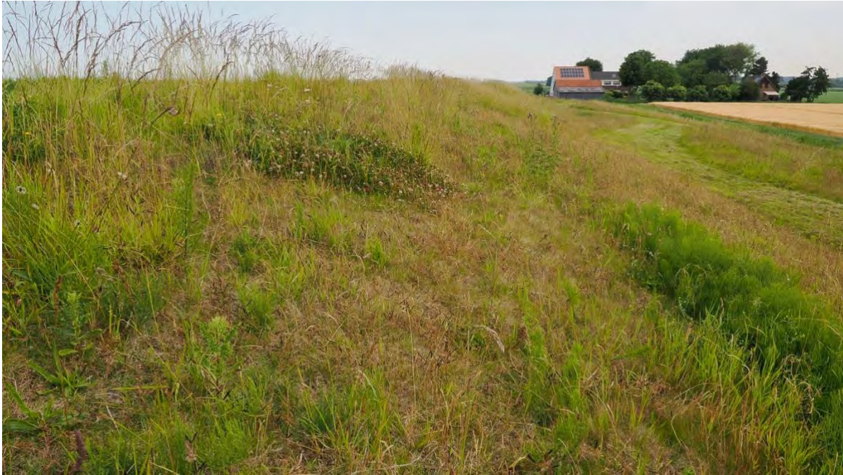
Foto 12: veel droge en dorre plekken op 13 juni 2025 op het talud van de Westdijk
